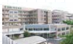
5 独立行政法人 国立病院機構埼玉病院 所在地：埼玉県和光市諏訪2-1 病床数：550
